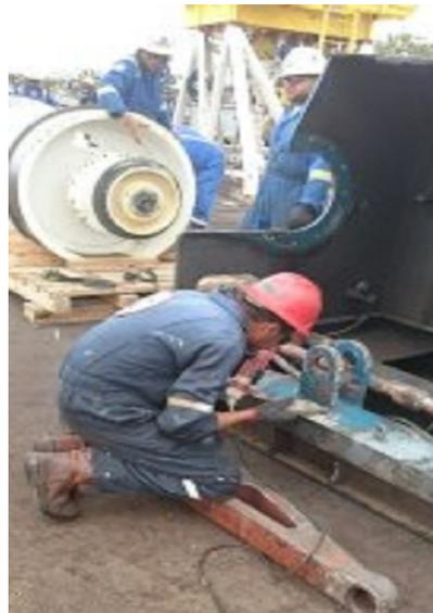
Foto 10.- Trabajo de Inspección Barra ecualizadora de Malacate .
